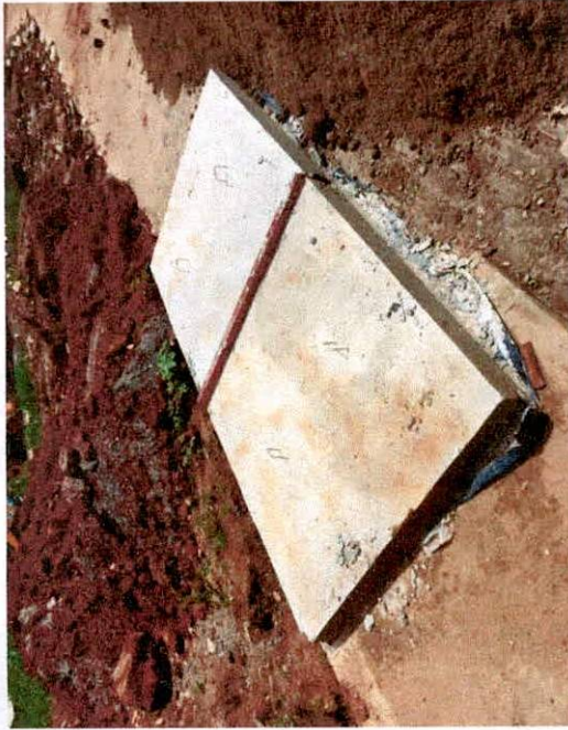
Construção de caixa com fundo e tampa
