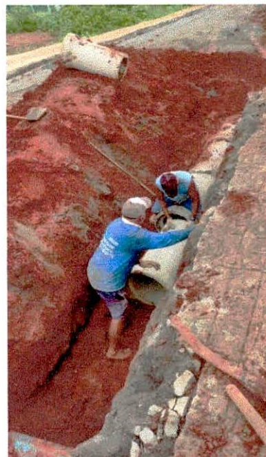
Assentamento de tubo de 400mm
