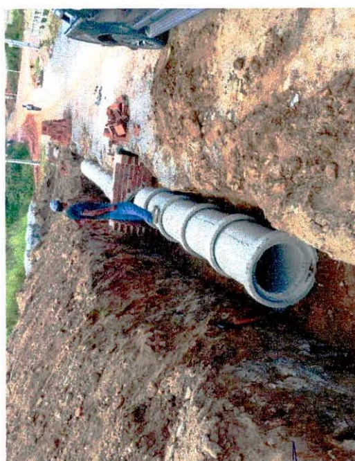
Assentamento de tubo de 600mm
