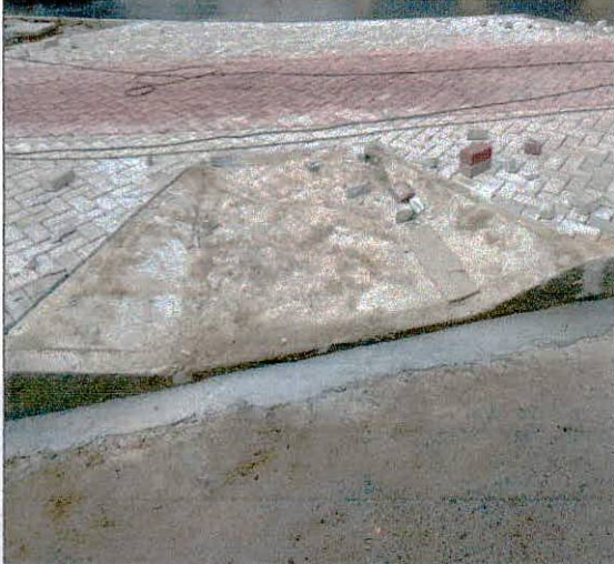
Foto 75: Rampas de acessibilidade executadas.
