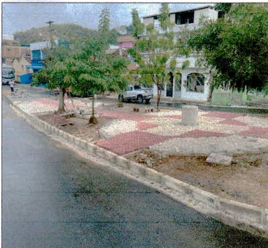
Foto 09: Execução de passeios em intertravados.
