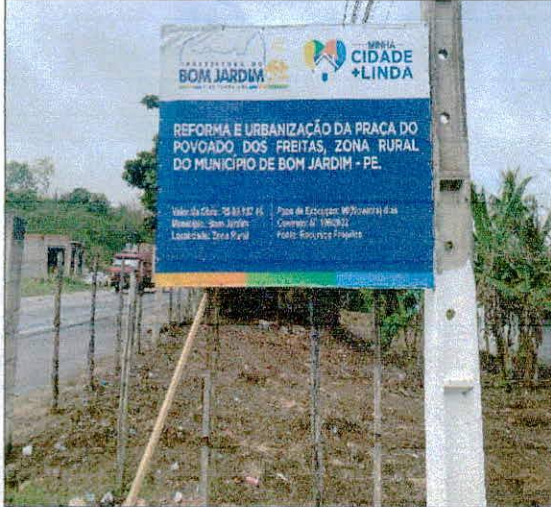
Foto 01: Placa de Obra instalada.
