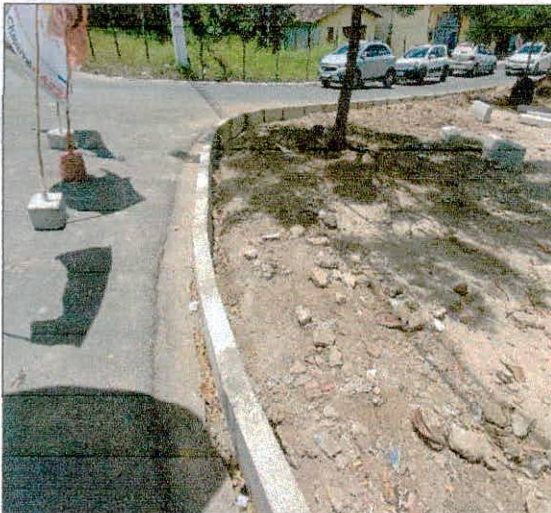
Foto 03: Demolições e remoções executadas.
