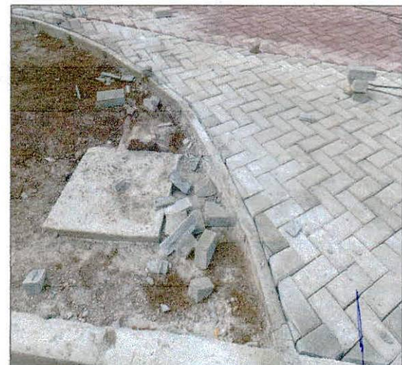
Foto 06: Assentamento de guias de divisão de intertravados executado.
