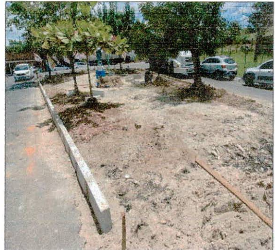
Foto 04: Assentamento de Guia meio-fio.
