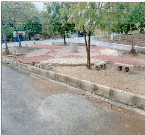
Foto 05: Assentamento de Guia meio-fio executado.
