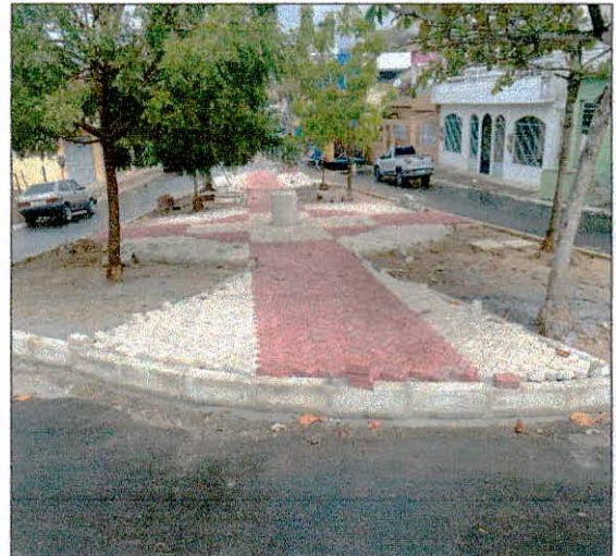
Foto 10: Execução de passeios em intertravados.
