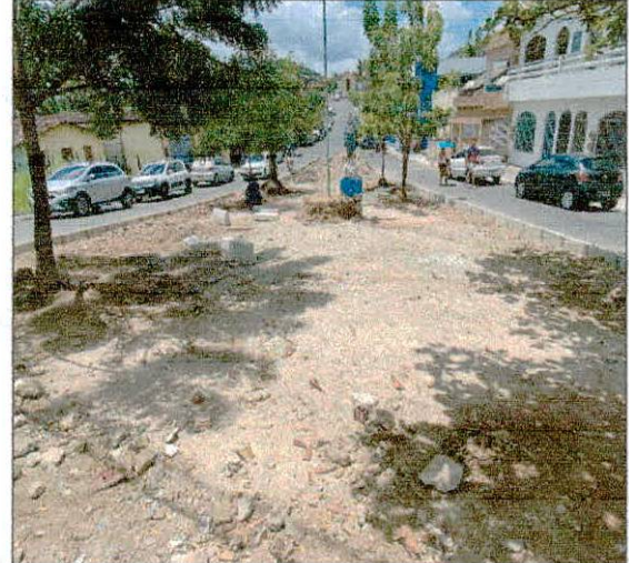
Foto 02: Demolições e remoções executadas.
