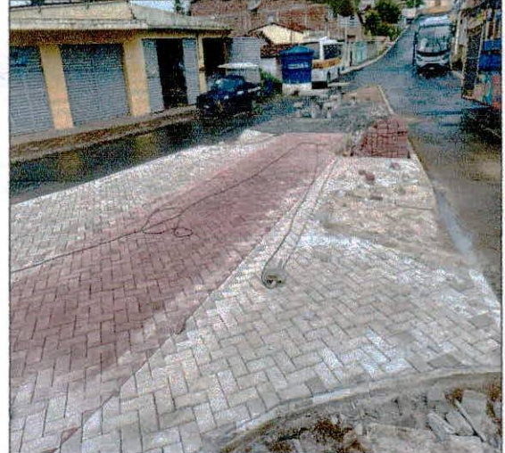
Foto 86: Execução de passeios em intertravados.
