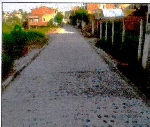
Foto 03: Execução de pavimentação na rua da Celpe trecho 02.
