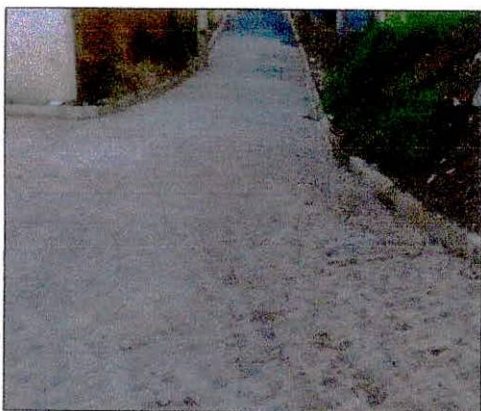
Foto 01: Execução de pavimentação na rua da Celpe trecho 01.
