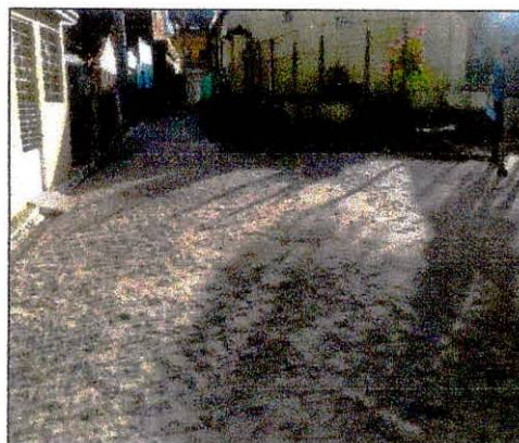
Foto 02: Execução de pavimentação na rua da Celpe trecho 01.
