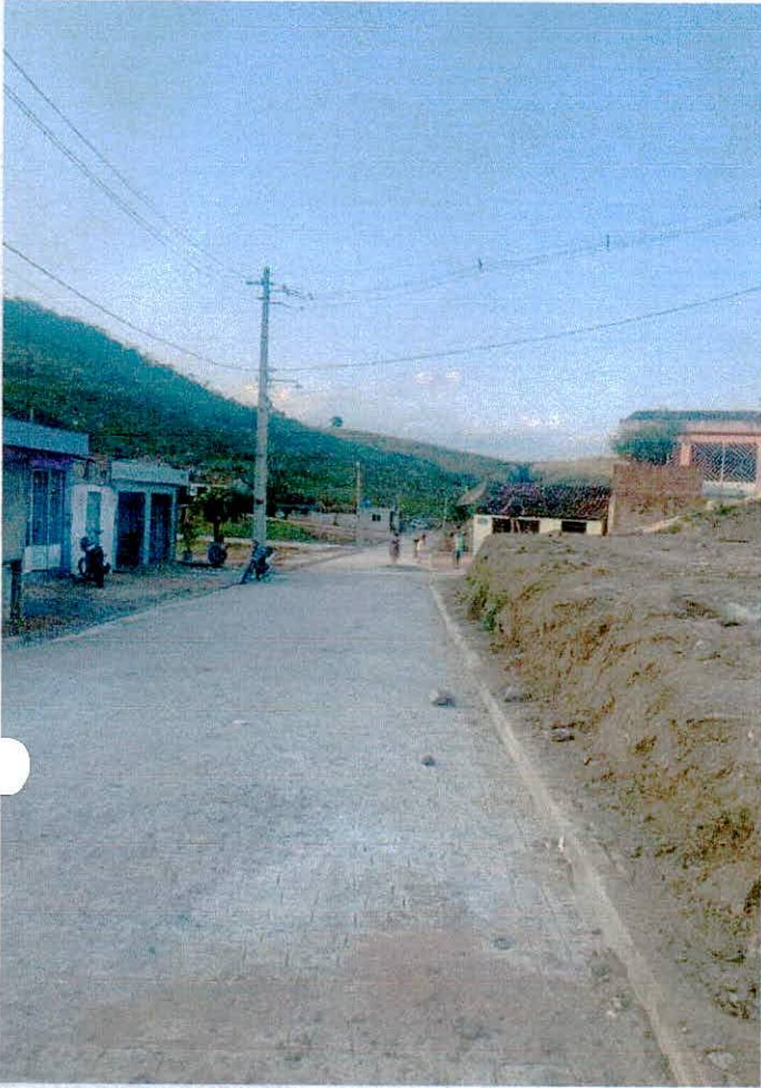
Rua Córrego do Aruá 02
