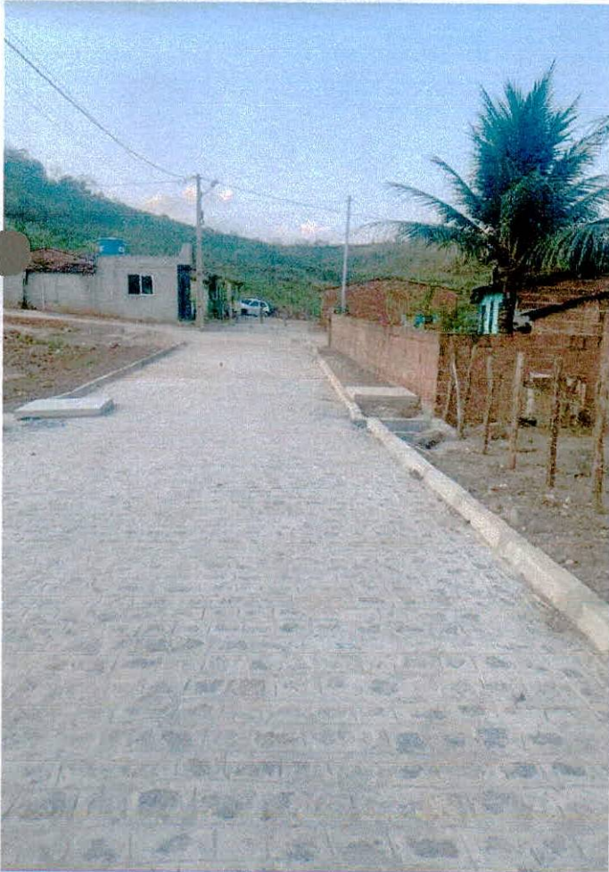
Rua Córrego do Aruá 02
