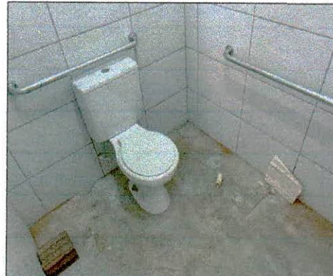
Foto 16: Vasos e barras de apoio instalados.
