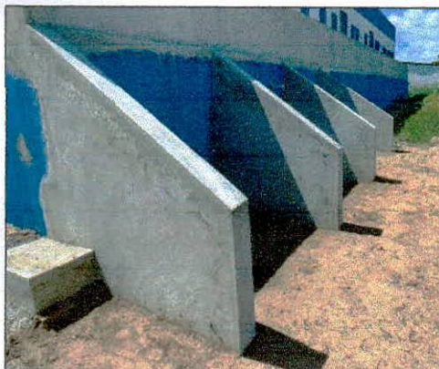
Foto 03: Chapisco e reboco dos Contrafortes.
