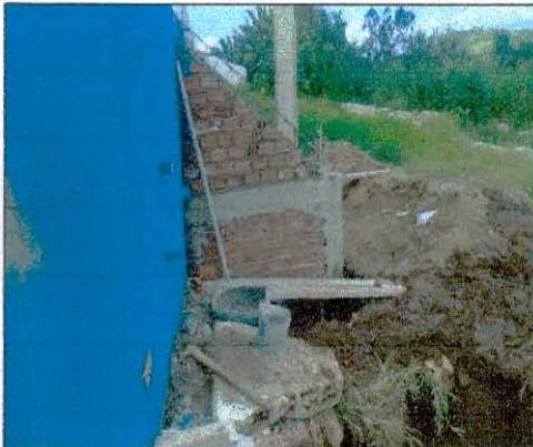
Foto 01: Alvenaria dos contrafortes.
