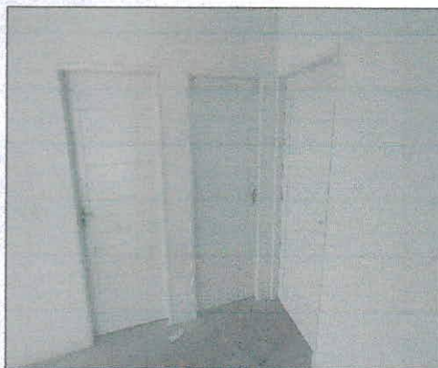
Foto 23: Pintura das portas de madeira executadas.
