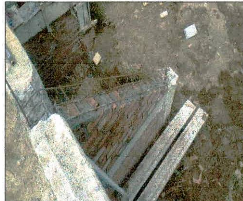
Foto 02: Execução de pilares vigas e fundação dos contrafortes.
