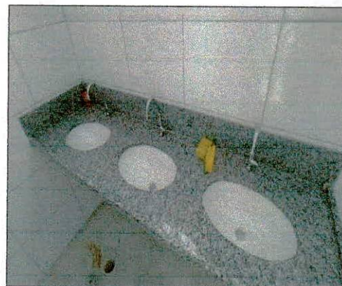
Foto 18: Cubas de louças brancas instaladas.
