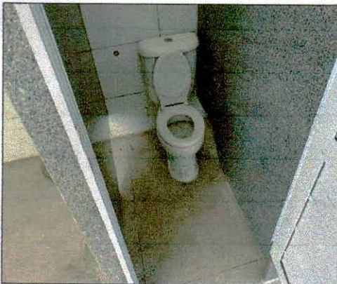
Foto 15: Vasos Sanitários instalados.
