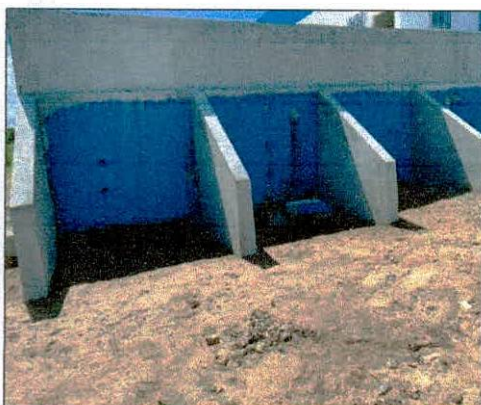
Foto 05: Muro e contrafortes executados.
