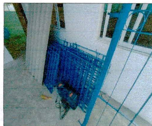
Foto 24: Pintura das esquadrias de metal executada.
