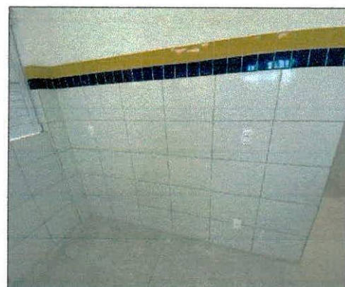
Foto 12: Interruptores e tomadas instalados.
