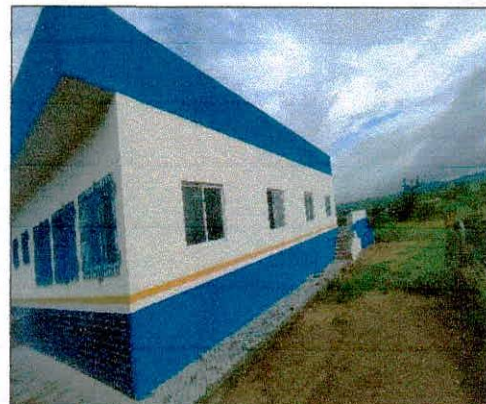
Foto 10: Pintura externa executada.
