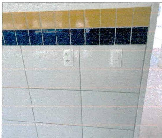
Foto 10: Aplicação de cerâmicas executada.
