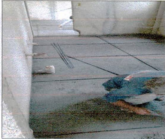
Foto 13: Execução de piso granilite das salas.
