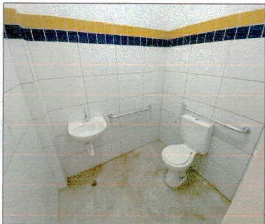
Foto 11: Aplicação de cerâmicas executadas.
