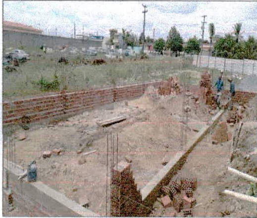
Foto 01: Execução de pilares e vigas de concreto armado das novas salas.
