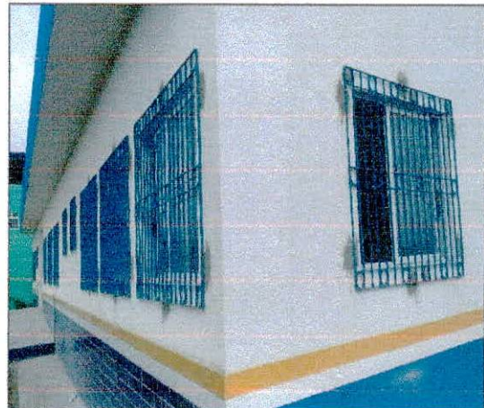
Foto 20: Instalação de grades das janelas executada.
