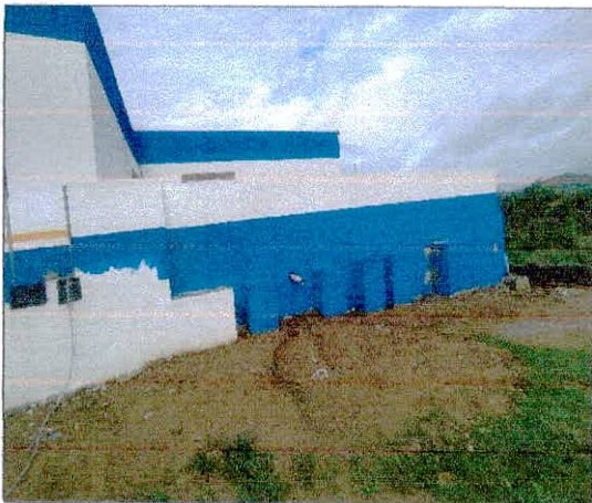
Foto 21: Execução de pintura das paredes externas.
