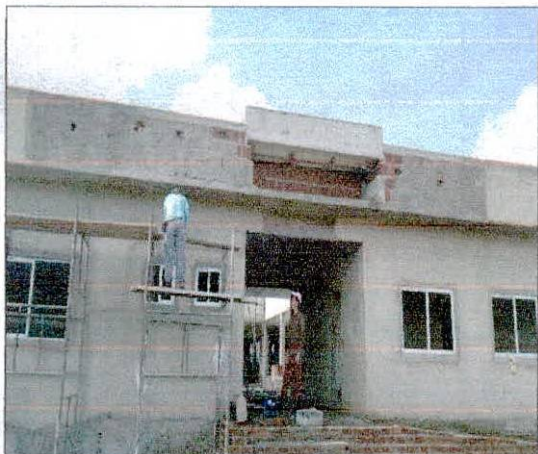
Foto 09: Execução de chapisco e reboco de fachadas.
