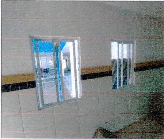
Foto 19: Janelas de alumínio instaladas.
