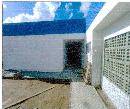
Foto 22: Execução de pintura das paredes externas.
