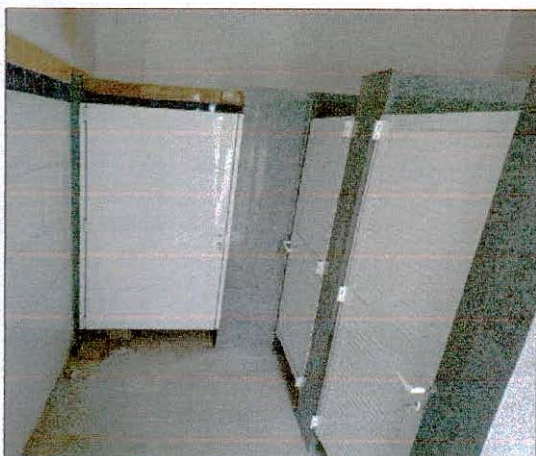
Foto 17: Portas de alumínio instaladas.
