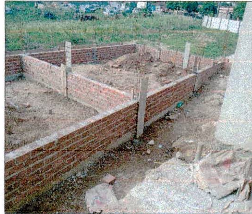
Foto 02: Execução de pilares e vigas de concreto armado das novas salas.
