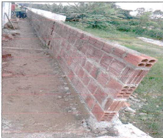
Foto 07: Execução de alvenarias do muro.
