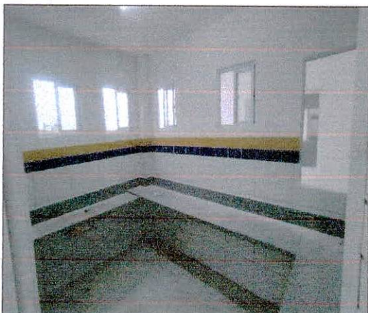
Foto 23: Execução de pintura em ambientes internos.
