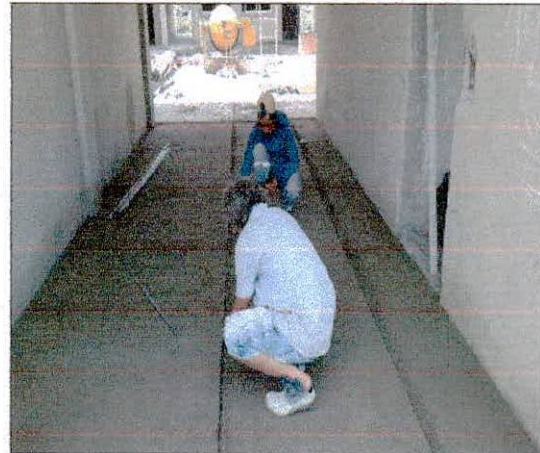
Foto 14: Execução de piso granilite das áreas de circulação.
