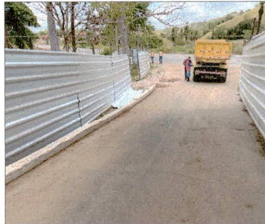
Foto 04: Isolamento da com tapume metálico executado.
