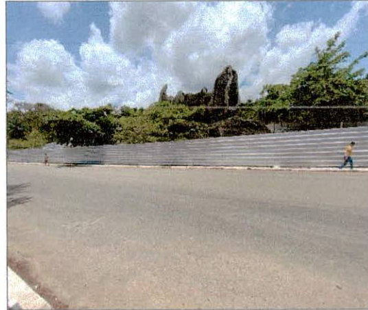
Foto 02: Isolamento da com tapume metálico executado.
