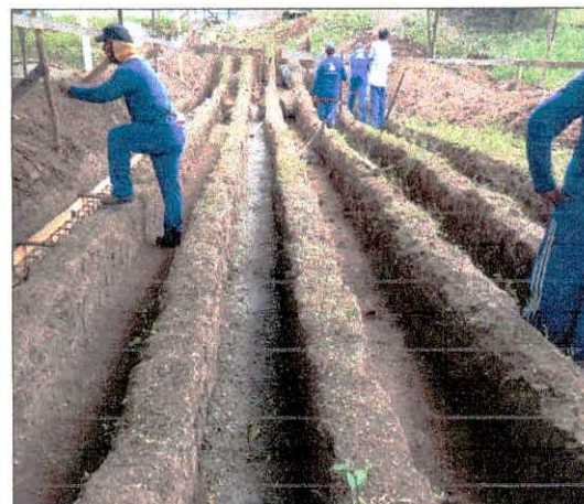
Foto 10: Aplicação de concreto magro para lastro.
