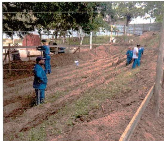
Foto 08: Execução de escavação de valas para as arquibancadas.
