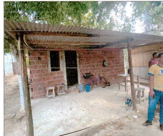
Foto 06: Escritório de alvenaria executado.
