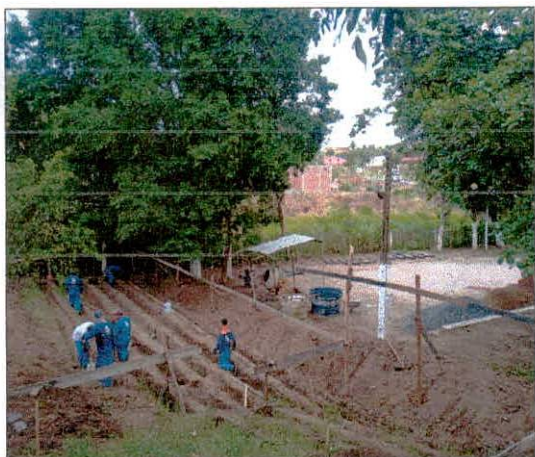
Foto 09: Execução de escavação de valas para as arquibancadas.
