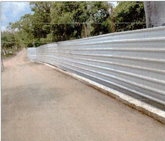
Foto 03: Isolamento da com tapume metálico executado.
