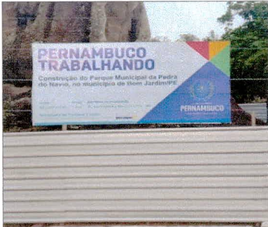
Foto 01: Placa de Obra instalada.
