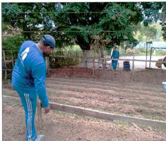
Foto 07: Locação de obra executada.
