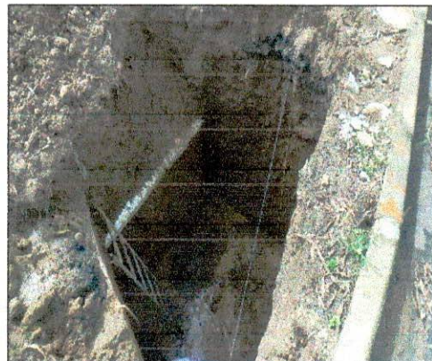
Foto 02: Escavação para assentamento das fundações executadas.
