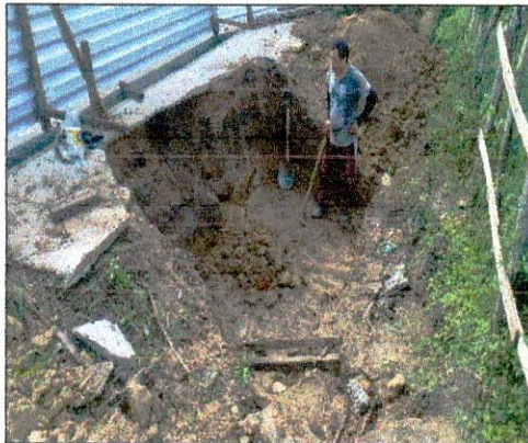
Foto 01: Escavação para assentamento das fundações.
