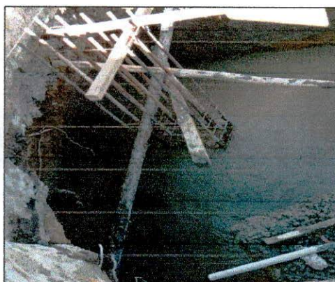
Foto 05: Fundações concretadas sapatas.
