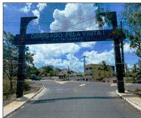
Foto 12: Construção de pórtico finalizada.
