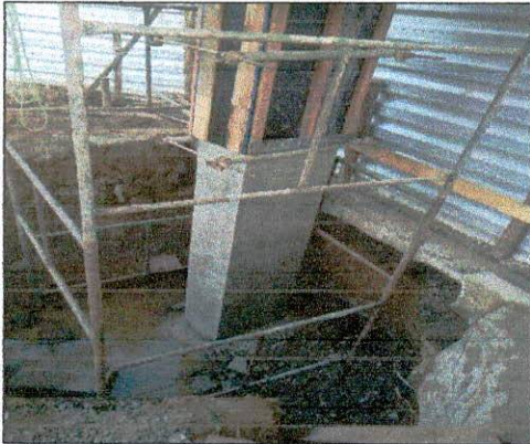
Foto 07: Execução dos pilares de concreto.
