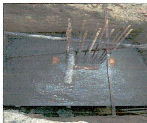
Foto 06: Fundações concretadas sapatas.
