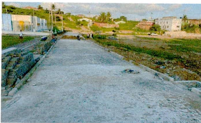
FOTO 01: EXECUÇÃO DE PAVIMENTO EM PARALELEPÍPEDOS
