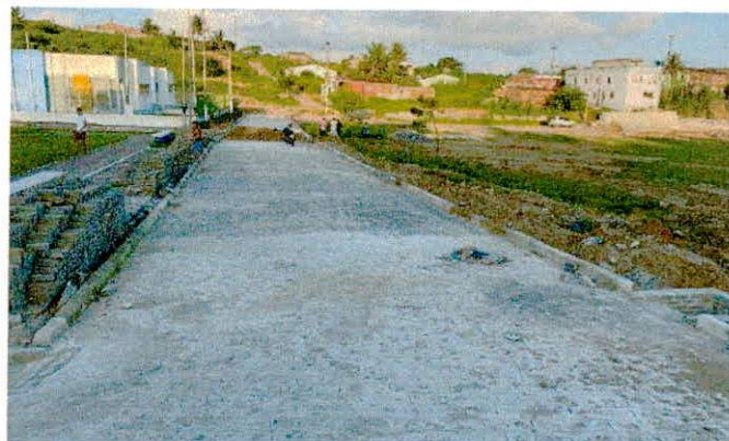
FOTO 02: EXECUÇÃO DE PAVIMENTO EM PARALELEPÍPEDOS
