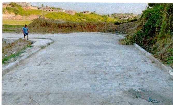
FOTO 04: RECOMPOSIÇÃO DE PAVIMENTO EM PARALELEPÍPEDOS
