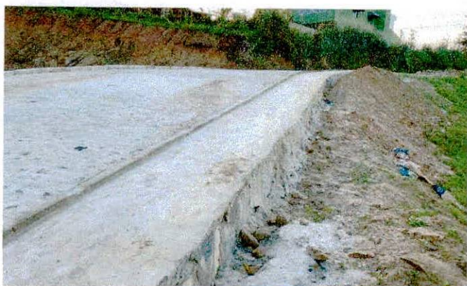
FOTO 05: ALVENARIA DE PEDRA ARGAMASSADA
