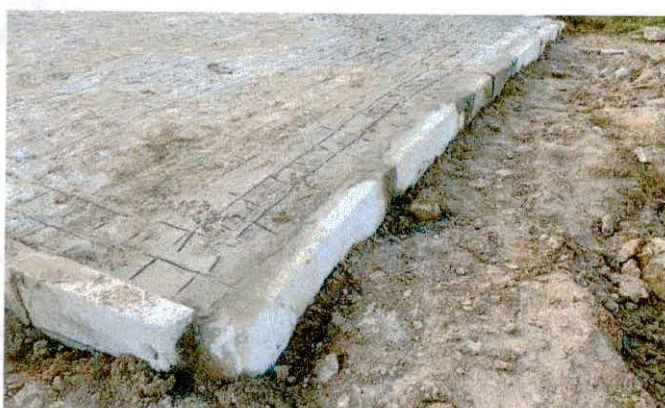
FOTO 03: RECOMPOSIÇÃO DE PAVIMENTO EM PARALELEPÍPEDOS
