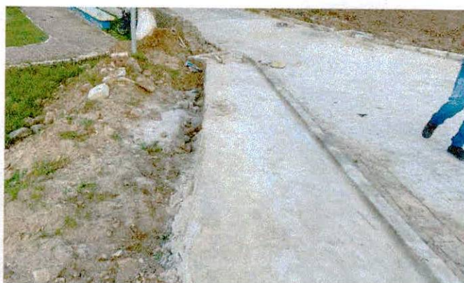
FOTO 06: ALVENARIA DE PEDRA ARGAMASSADA
