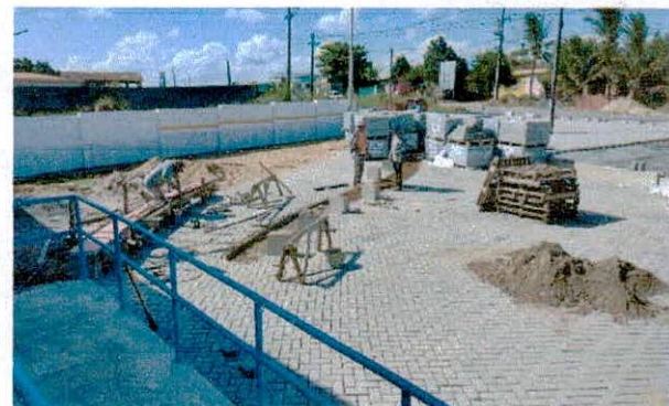
Foto 04: Execução de pavimentação intertravados
