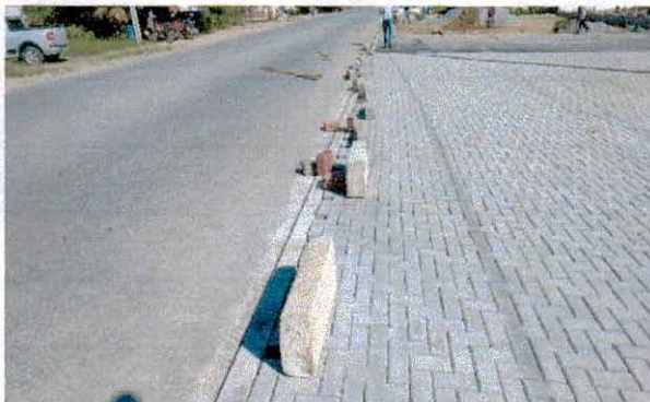
Foto 03: Execução de meio fio e pavimentação intertravados
