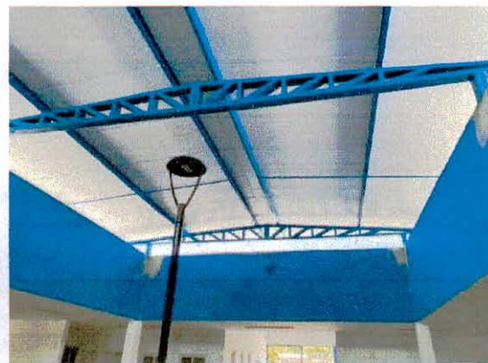
Foto 12: Estrutura metálica e coberta termo acústica
