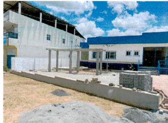
Foto 08: Execução de mureta de alvenaria
