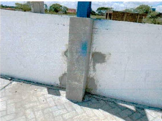
Foto 09: Pilar de sustentação de estrutura metálica
