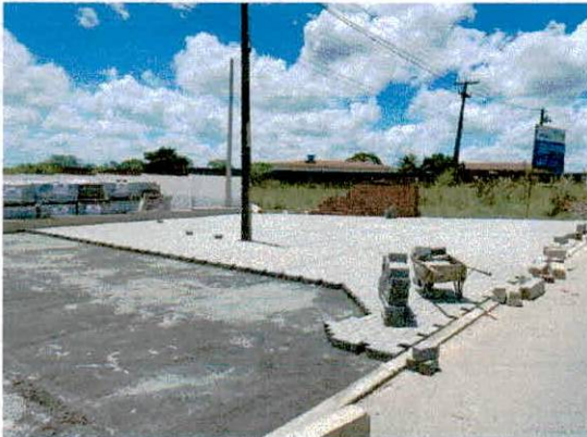
Foto 07: Execução de pavimentação intertravados
