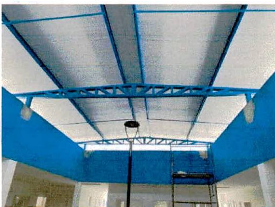
Foto 11: Estrutura metálica e coberta termo acústica
