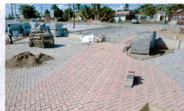
Foto 06: Execução de pavimentação intertravados
