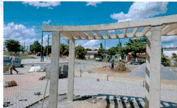
Foto 02: Execução de estrutura de pergolados
