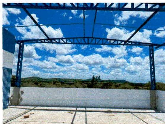
Foto 14: Execução de estrutura metálica
