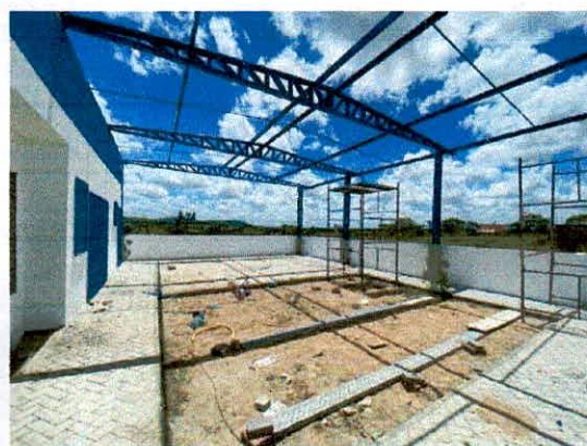
Foto 16: Execução de estrutura metálica
