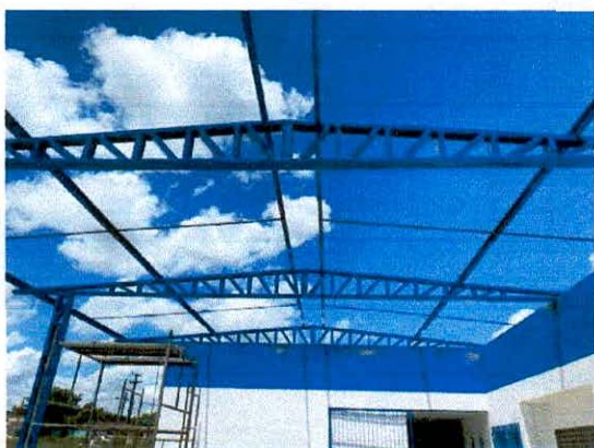
Foto 15: Execução de estrutura metálica
