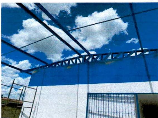
Foto 13: Execução de estrutura metálica
