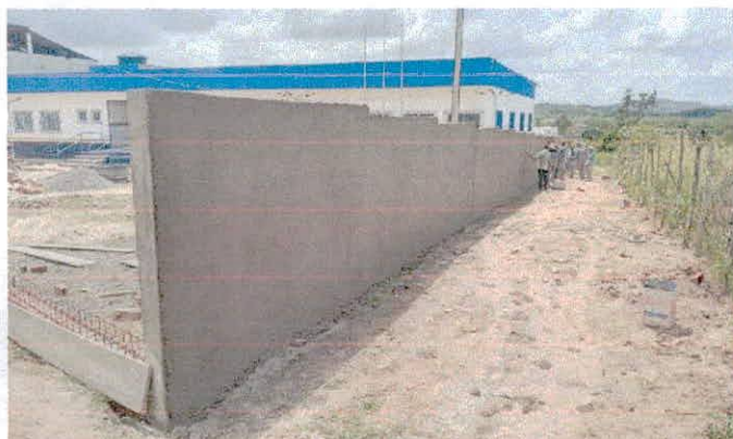
FOTO 01: Muro de Vedação da edificação
