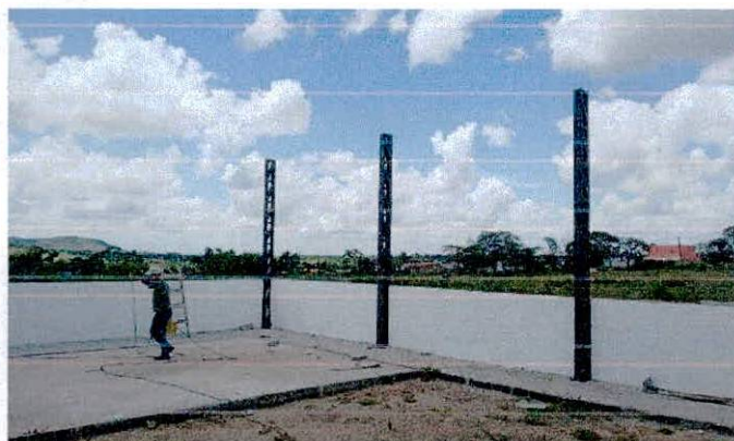
FOTO 05: Estrutura metálica da coberta
