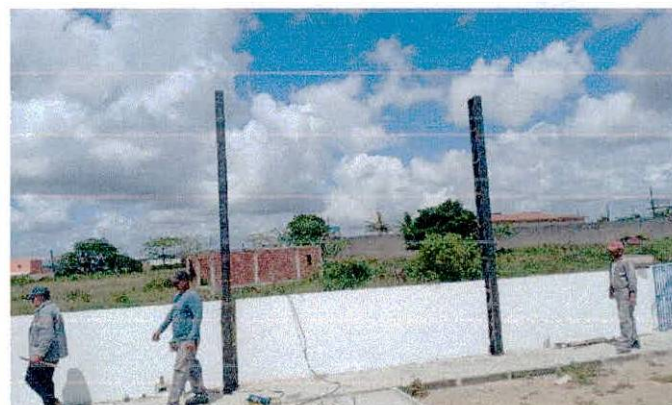
FOTO 04: Estrutura metálica da coberta
