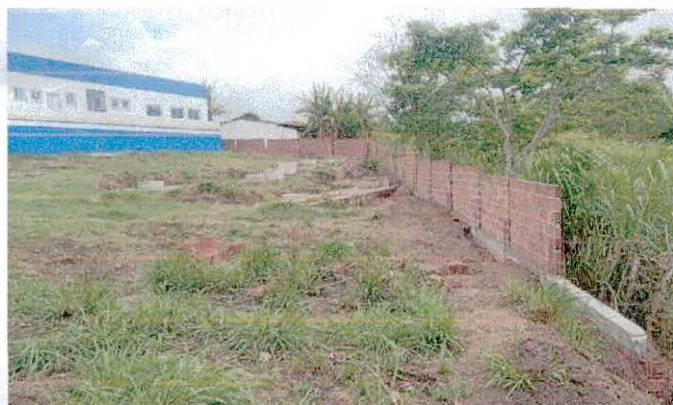
FOTO 03: Muro de Vedação da edificação
