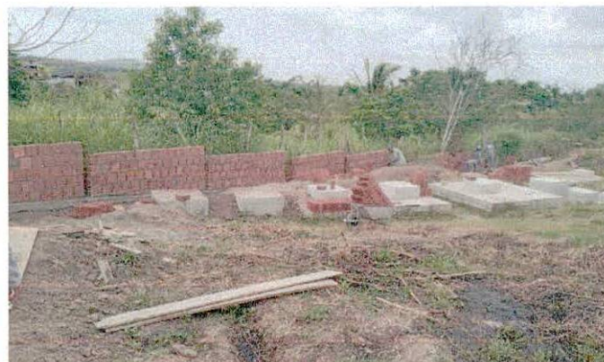
FOTO 02: Muro de Vedação da edificação
