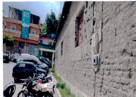
Foto 04: Demolição de revestimento
