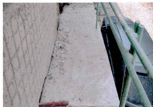
Foto 06: Laje da Área técnica
