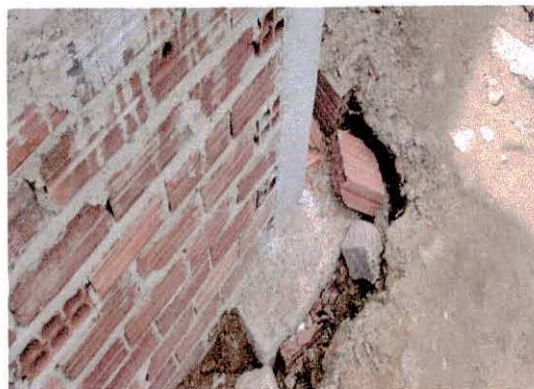
Foto 02: Escavação das Sapatas
