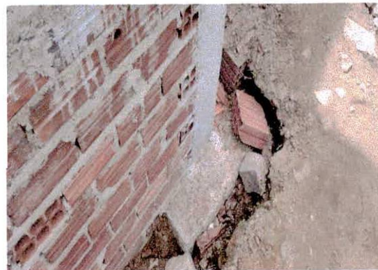
Foto 02: Escavação das Sapatas
