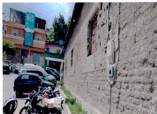
Foto 04: Demolição de revestimento
