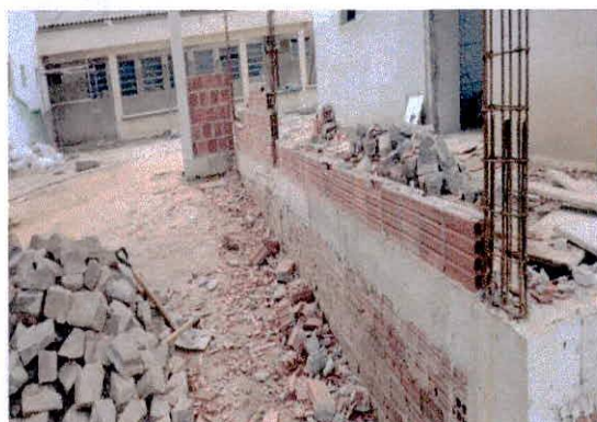
Foto 03: Estrutura de concreto armado
