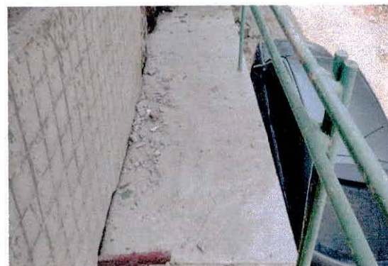
Foto 06: Laje da Área técnica
