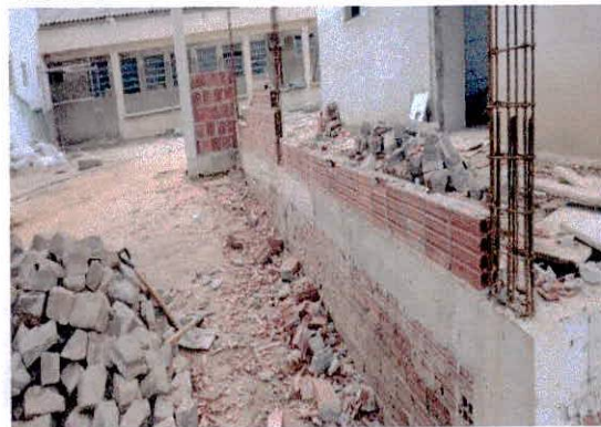
Foto 03: Estrutura de concreto armado
