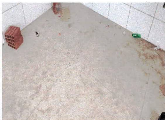
Foto 15: Piso em granilite
